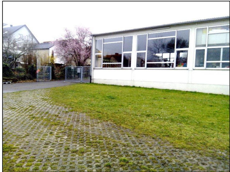
Abbildung 2. Sicht auf den nördlichen Teil der Feuerwehrstation und für das Gerätehaus geplante Fläche
